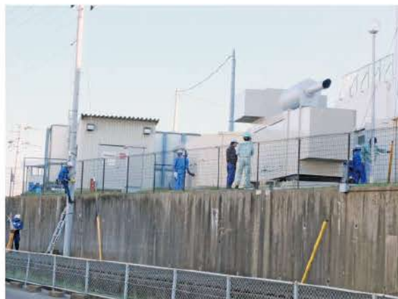
電気設備の点検
