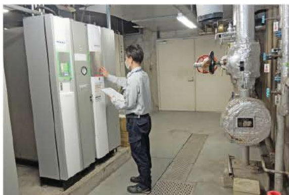
空調装置の点検
