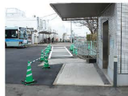
段差を解消した外のエレベーター付近
